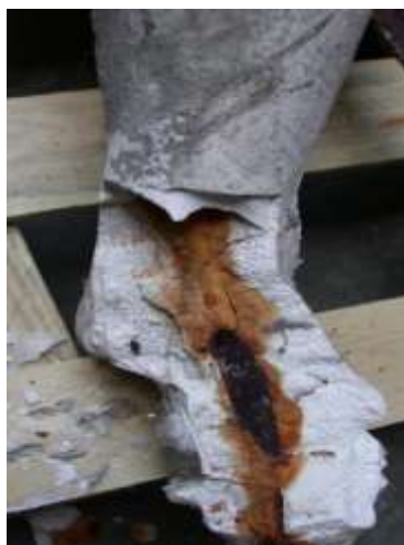
Plâtre armé dégradé par la corrosion du fer. Ph. Nathalie Le Dantec. INP
