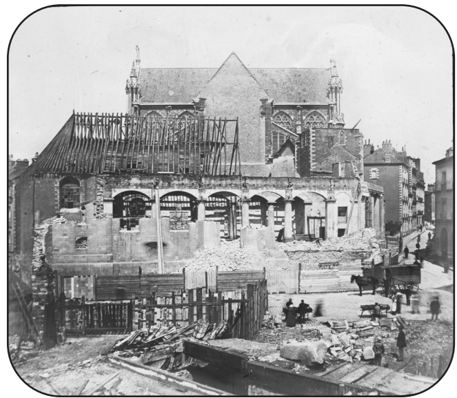
Démolition de la vieille église de Saint-Similien à Nantes, plaque de verre, fonds Soreau (cote VN 29-03). Société archéologique et historique de Nantes et Loire-Atlantique.
