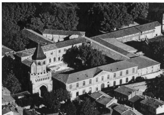
Vue aérienne de l'abbaye-école de Sorèze
